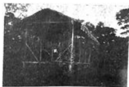
Capilla y escuela de Sabanetas, Ecuador, en construcción en plena selva.
