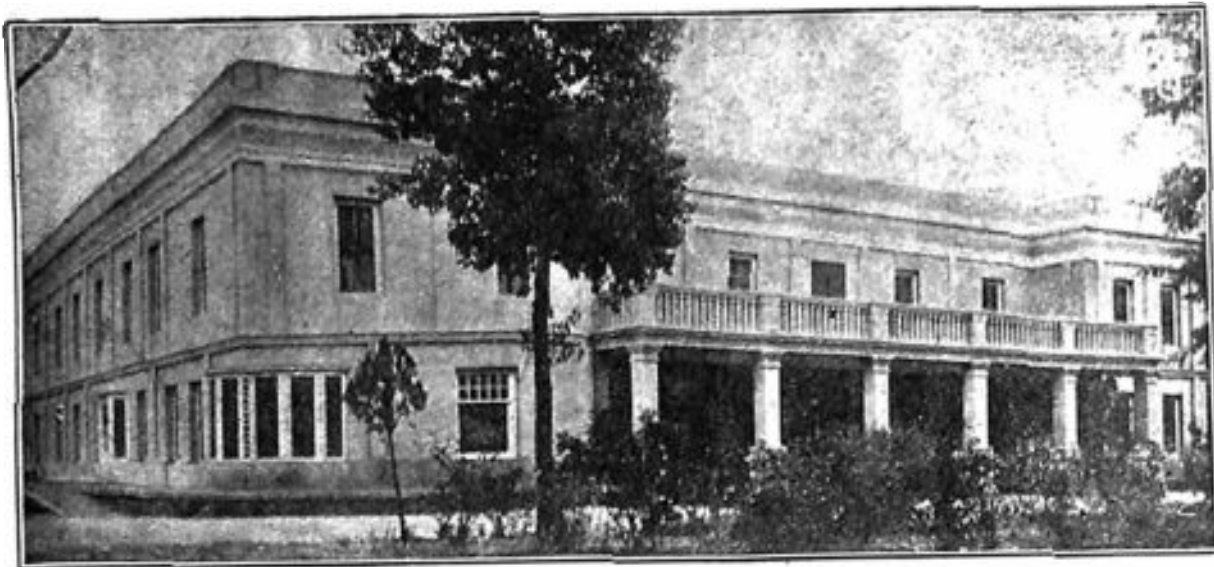
Aspecto del Sanatorio Adventista del Plata. Puzigari, R. Argentina. Situación que este edificio ocupa en cuanto a altura de edificio de esta clase.
