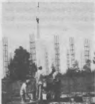
◀ Construcción del edificio para la radioemisora. En la parte posterior puede apreciarse la torre que sostendrá la antena.
