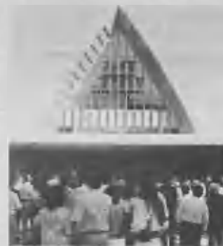
Fronte del flamante templo de Baradero, en la provincia de Buenos Aires.
