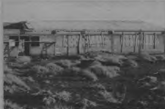
La Escuela Adventista de Zapala está siendo construida por los hermanos de la iglesia.
