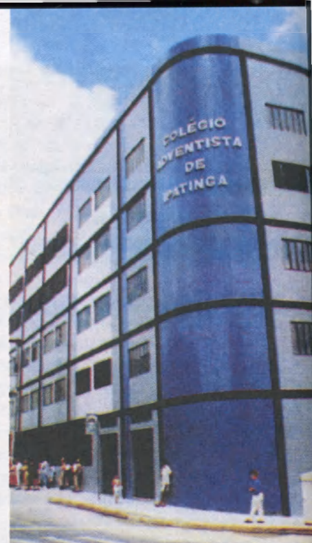
Vista panorámica de las nuevas instalaciones del Colegio Adventista de Ipatinga.
