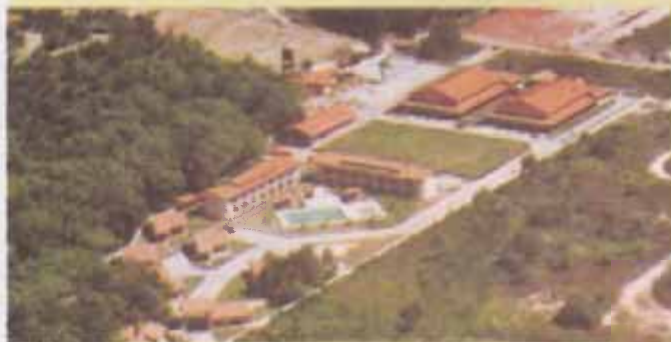
Vista aérea del centro recientemente inaugurado.
